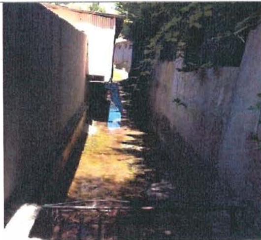
FIGURE 31 : ENTRÉE PASSAGE COUVERT IMPASSE DU TRIANON
