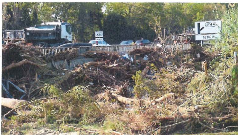
FIGURE 26 : FORMATIONS D'EMBÂCLES LORS DE LA CRUE DU 3 OCTOBRE 2015 SUR LE PONT DE L'AUTOROUTE A8
