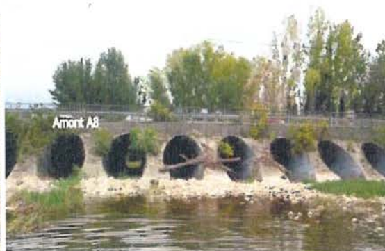
FIGURE 6 : EMBÂCLES SUITE À LA CRUE DU 3 OCTOBRE 2015 AU DROIT DE L'A8
