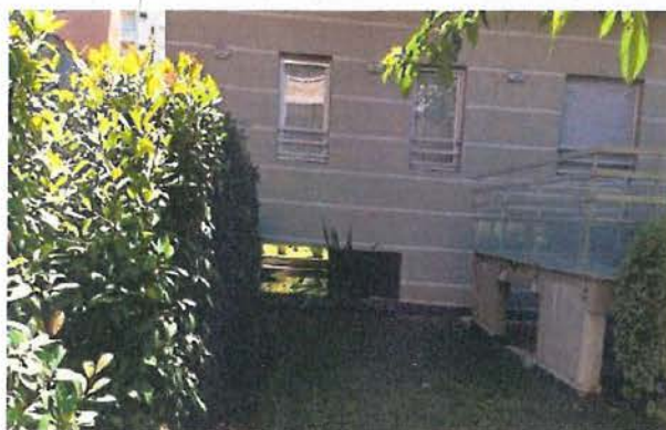
FIGURE 30 : EXEMPLE D'HABITATION FRÉQUEMMENT INONDÉE SITUÉE AU NIVEAU DU THALWEG ORIGINAL
