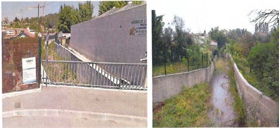
FIGURE 9 : LE VALLON DES HORTS AU PONT DES CABOTS ET AU PONT CAMATTE
